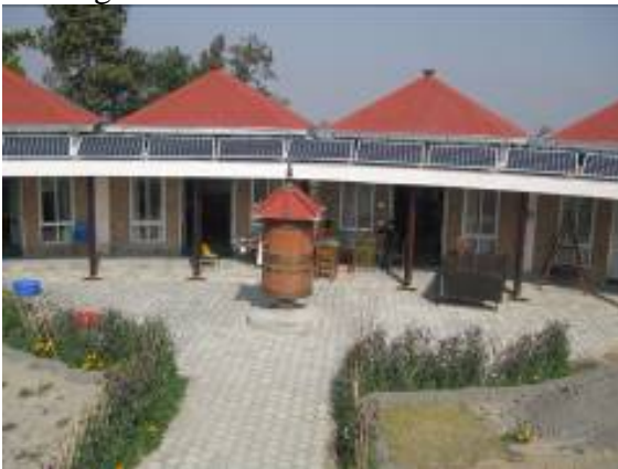
Zonnepanelen op het dak
