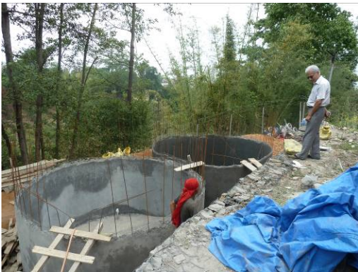
2 watertanks van elk 25.000 liter in constructie
